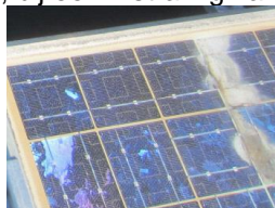
Paneel is 15 jaar oud en vertoont zichtbare gebreken.
