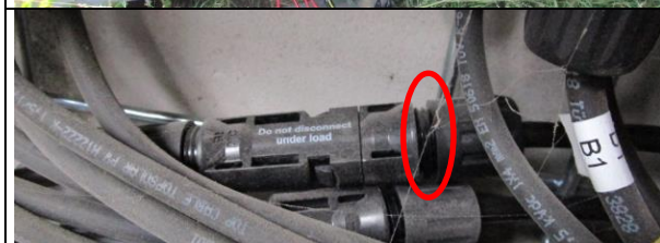
Bevestiging connector niet volledig aangedraaid.
