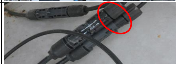
Connector volledig aangedraaid.
